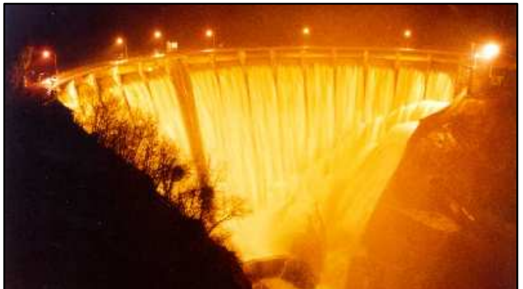
Vista notturna della diga
