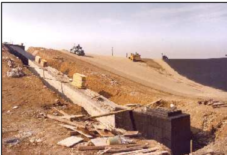
Cuncilo di ispezione e raccolta drenaggi
