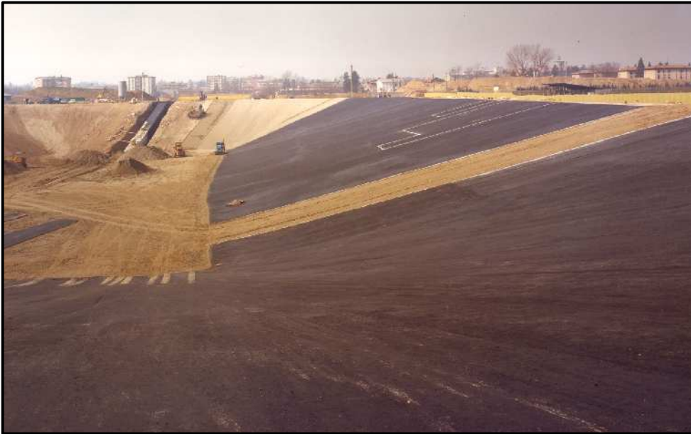
Impermeabilizzazione della vasca
