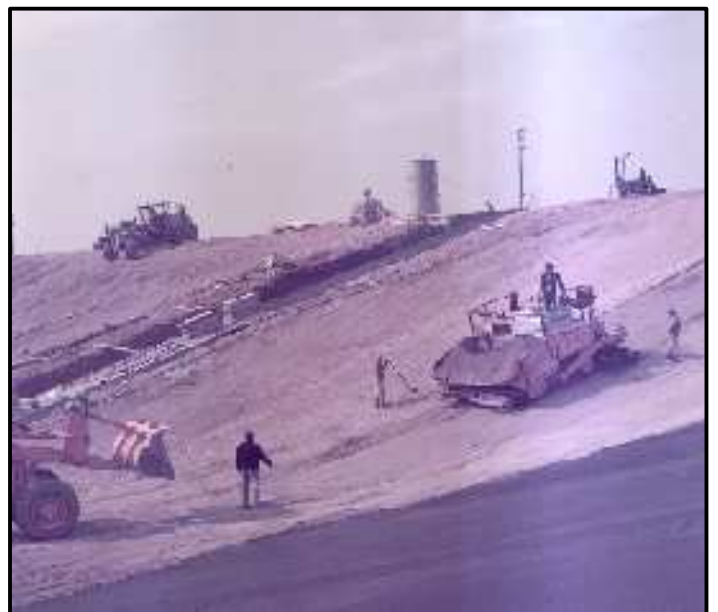
Impermeabilizzazione della vasca
